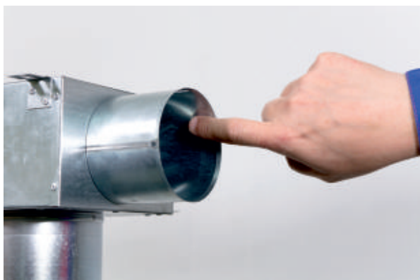
3) Vnitřní povrch vyústku namažeme kluzným přípravkem*.
