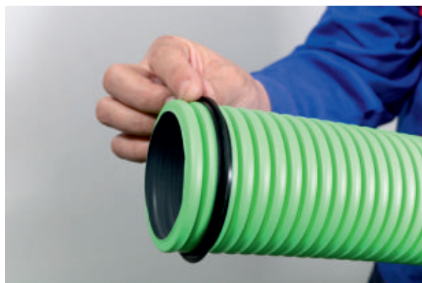
2) Do 2. nebo 3. drážky nasadíme těsnící kroužek.
