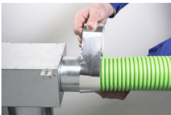
7) Spoj zajistíme vzduchotěsnou lepicí páskou.
