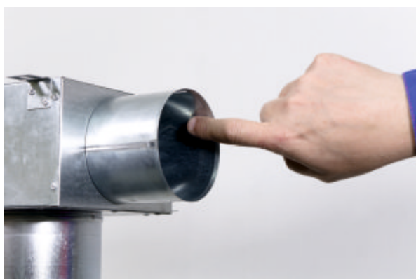
3) Vnitřní povrch vyústku namažeme kluzným přípravkem*.
