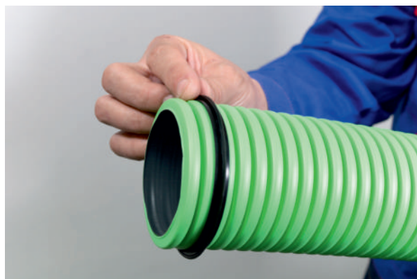
2) Do 2. nebo 3. drážky nasadíme těsnící kroužek.
