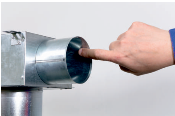
3) Vnitřní povrch vyústku namažeme kluzným přípravkem*.
